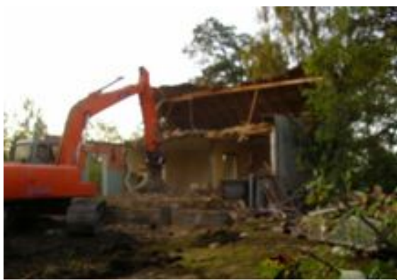
NCC, Viertolantie 29, Klaukkala
